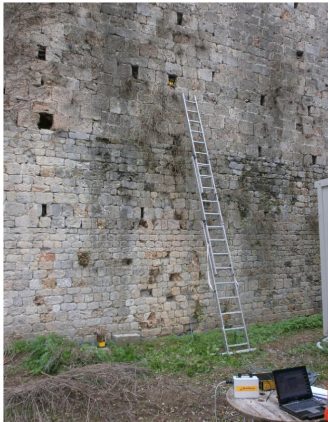
Monitoraggio di vibrazioni sull'antica cinta muraria di PISA
