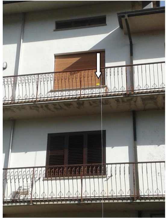
Esempio di posizionamento del secondo velocimetro Veloget 3D al piano elevato dello stesso edificio
