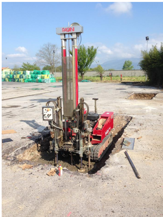
Prova penetrometrica statica-dinamica all'interno di piazzola appositamente predisposta - Porcari (LUCCA)
