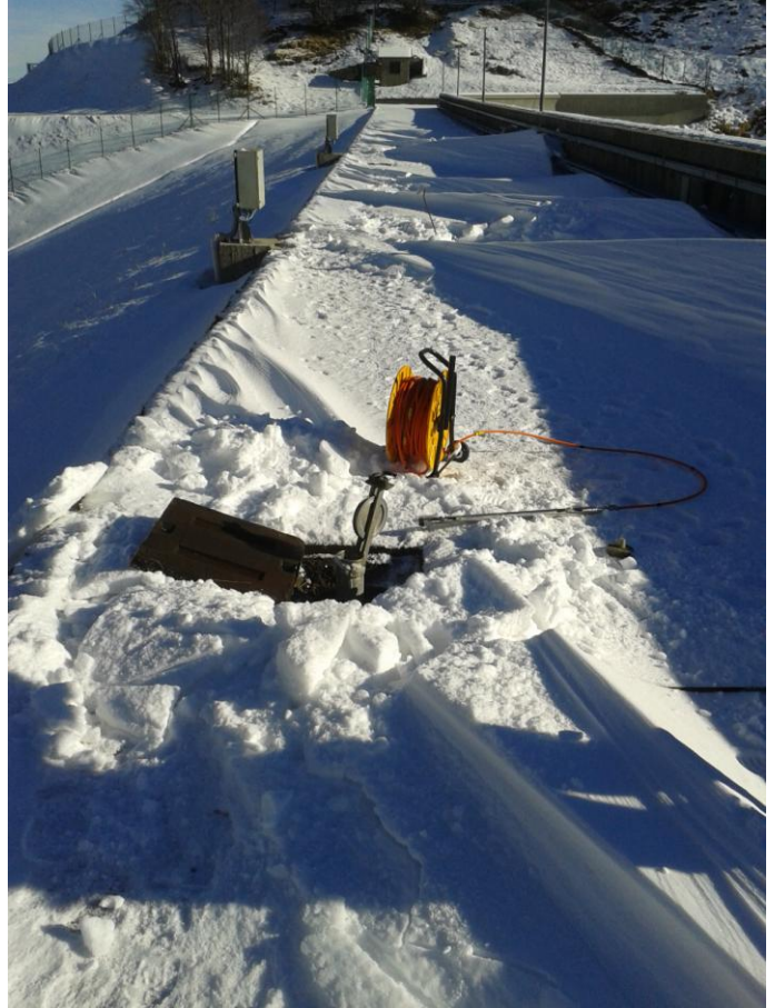
Misure inclinometriche sul corpo diga del lago artificiale di Paduli (MS)
