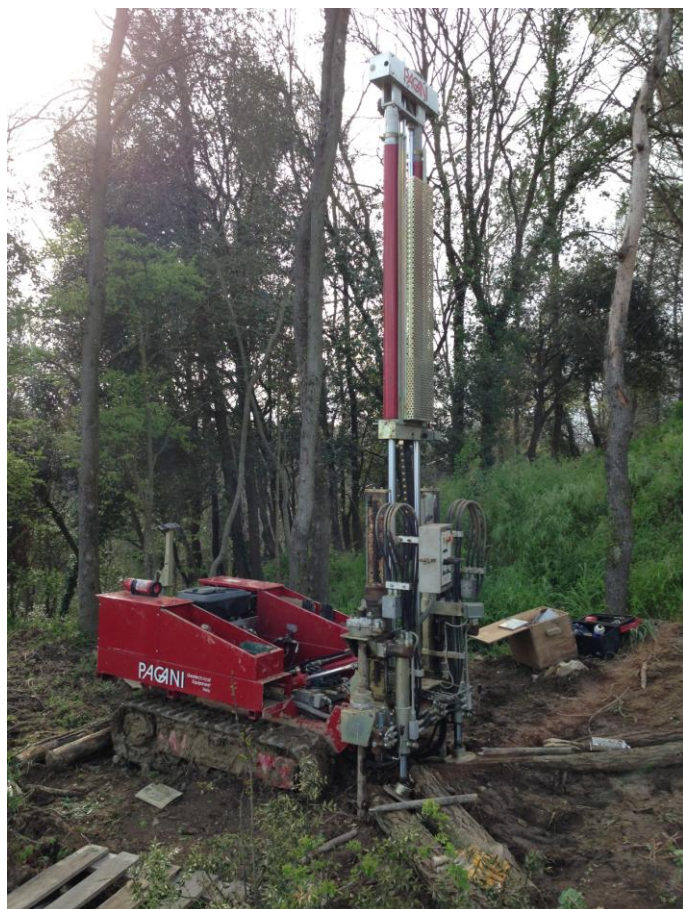
Prova penetrometrica statica-dinamica alla testa di versante in frana - Ponte alla Navetta (PISA)
