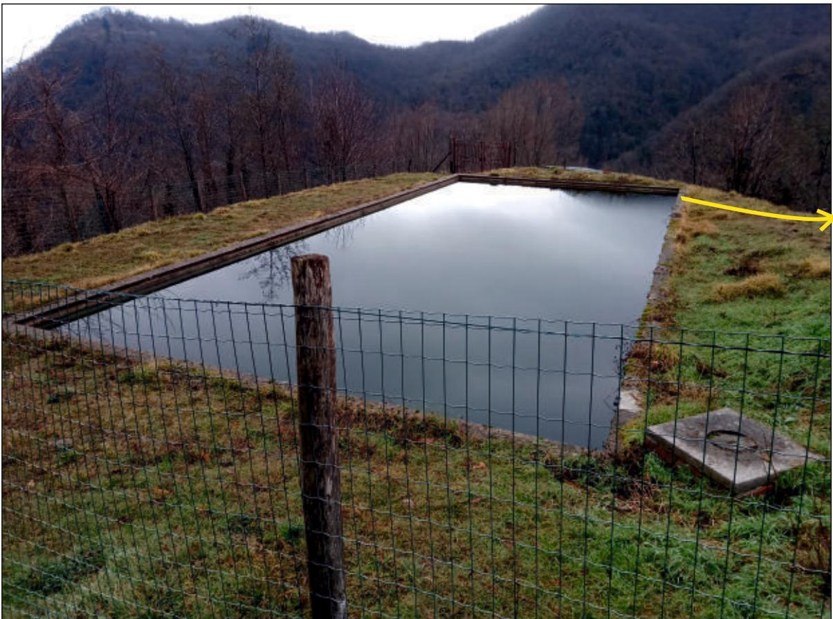
Fig.4 -Vista dell'invaso, in basso a destra pozzetto di arrivo delle acque; in giallo ubicazione dello scarico del troppo pieno
